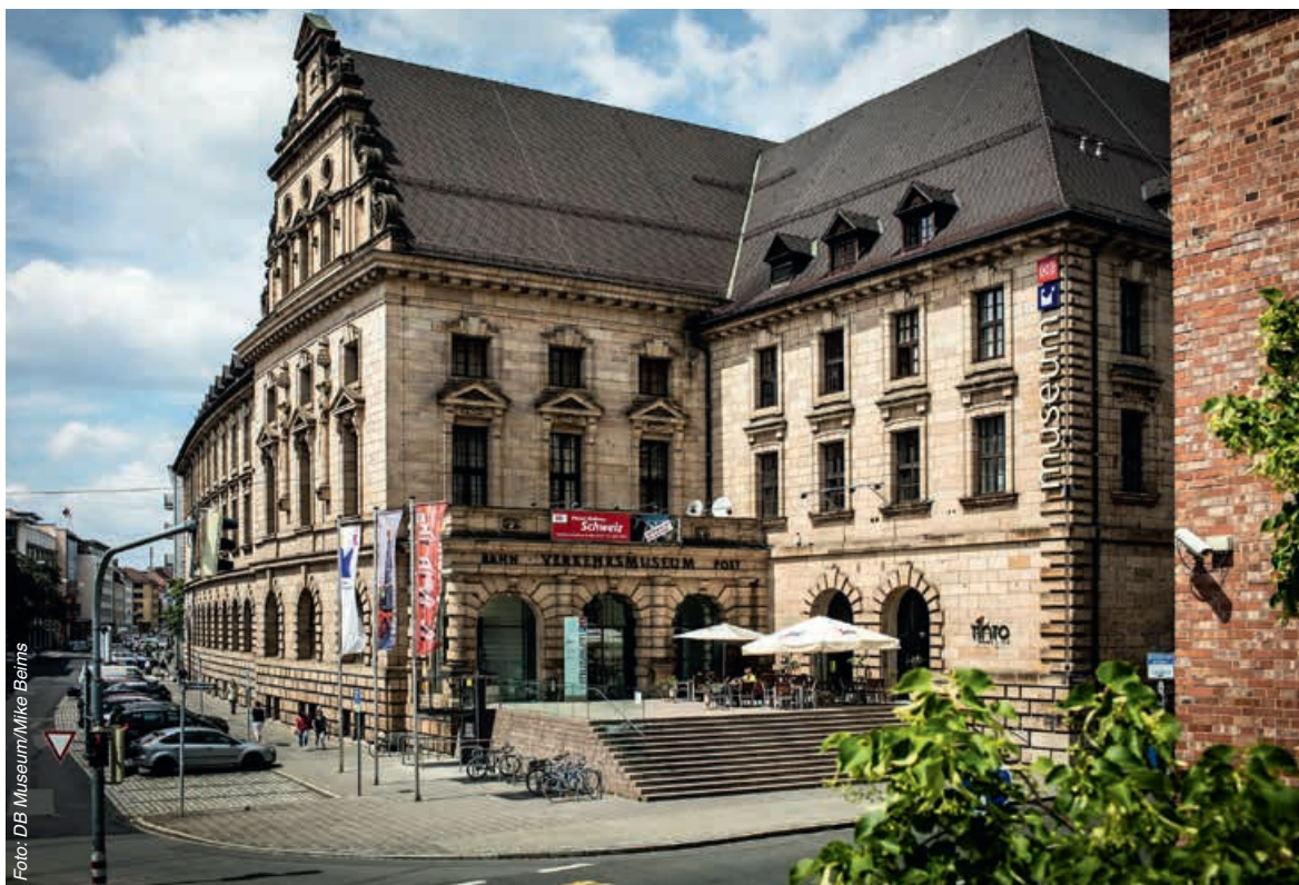
Das im Jahr 1882 gegründete DB Museum ist das älteste Eisenbahnmuseum der Welt. Rund 200.000 Gäste jährlich besuchen das Stammhaus in Nürnberg und die Außenstellen in Koblenz und Halle (Saale)
