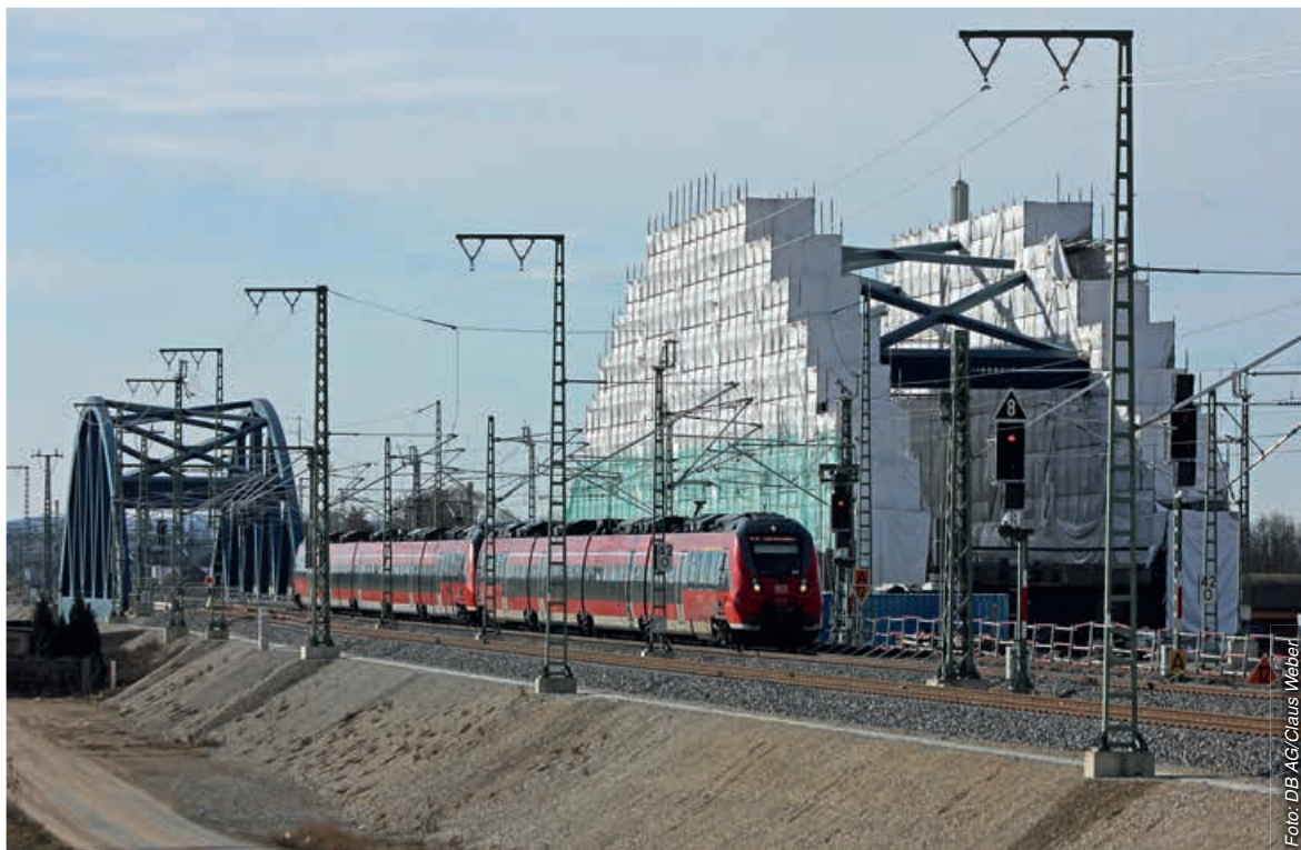
Eine noch verhüllte Eisenbahnbrücke bei Forchheim vor dem Einbau
