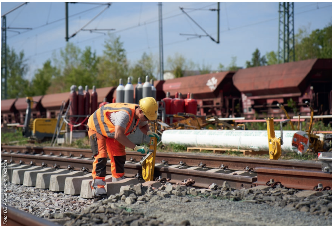
Gleisbauarbeiten auf der Riedbahn
