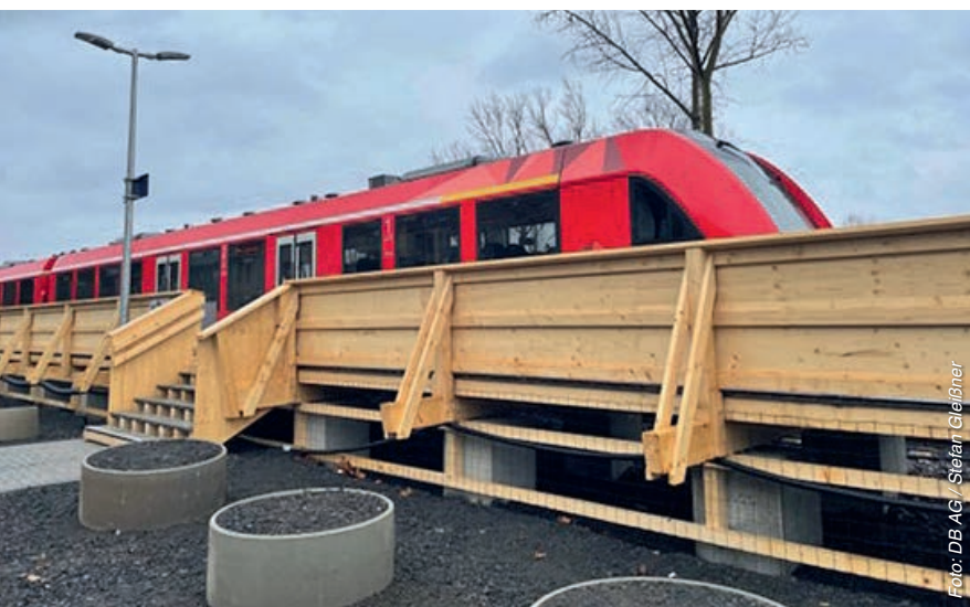
Wiederherstellung des Gleises am Haltepunkt Heimersheim mit Errichtung eines provisorischen Bahnsteigs
