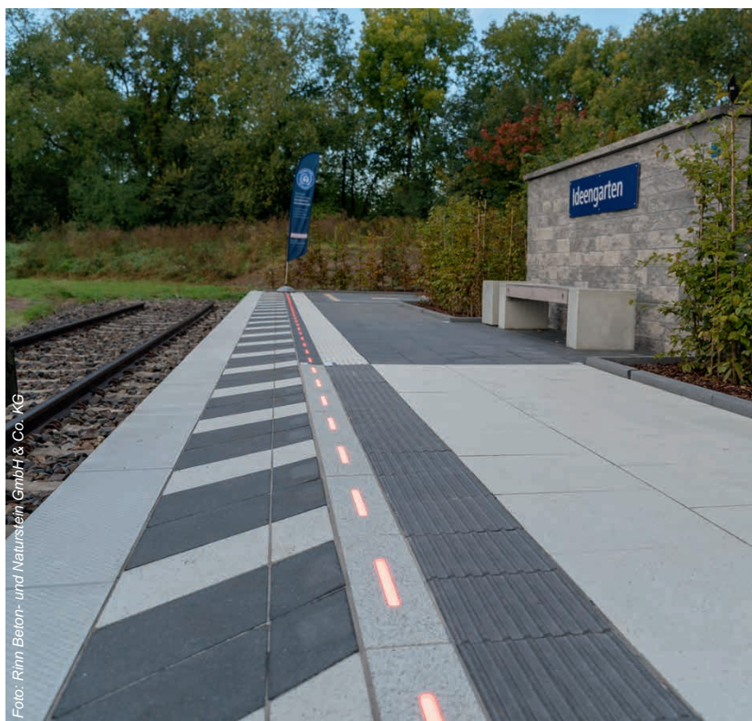
Smartes LED-System: Lichtmuster in Rot warnen Reisende vor ein- oder durchfahrenden Zügen
