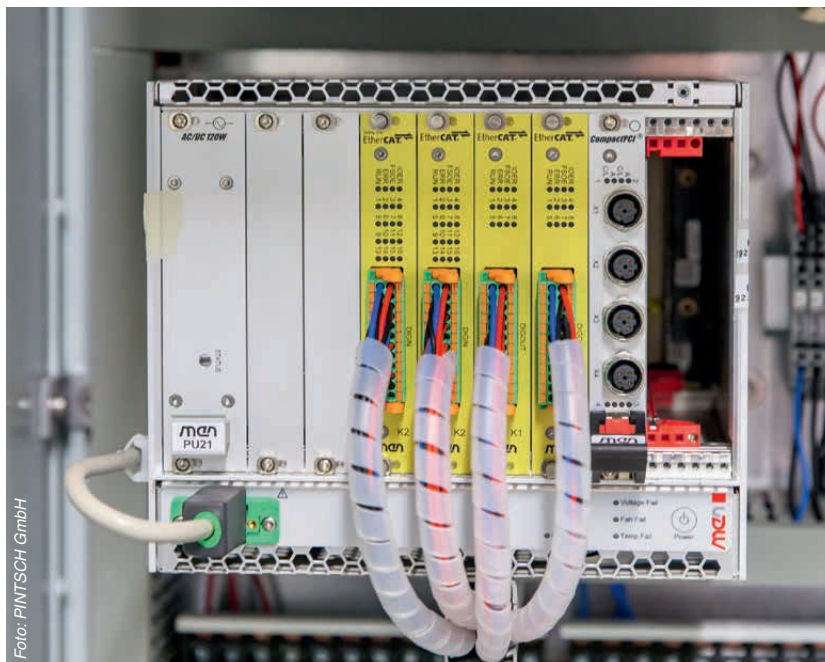
Moderne COTS (Commercial off the shelf) Hardware als Basis für digitale Leit- und Sicherungstechnik
