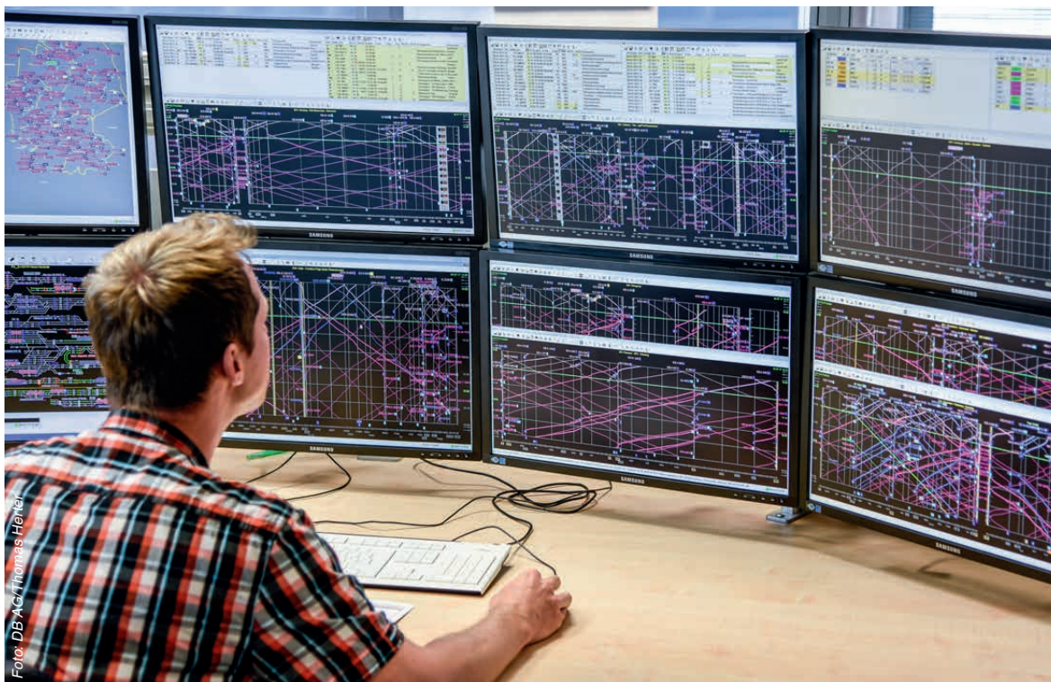
Netzleit- zentrale Frankfurt am Main: Die Besonderheit des Bahn- systems ist seine Komplexität
