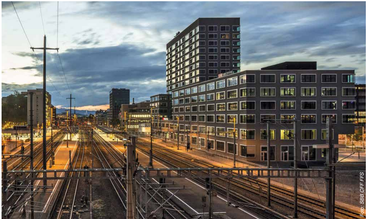
Fernwärme-Zentrale für die nachhaltige Energieversorgung der SBB-Gebäude im Umfeld des Bahnhofs Zürich-Altstetten
