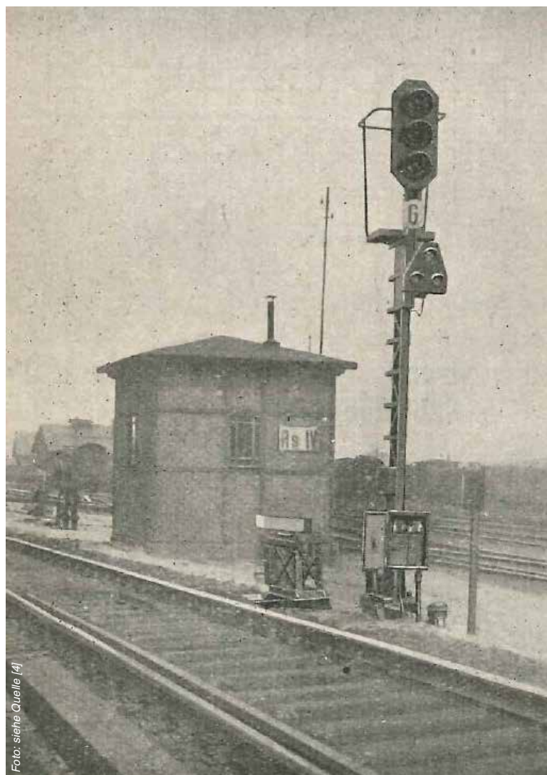
Abbildung 2: Ad-Signal als Vorläufer des späteren Ersatz- signals an einem Einfahrsignal des Bahnhofs York- straße in Berlin (um 1930)
